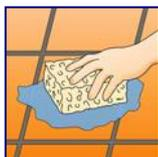
Sollten noch Reste von Fugenmörtel auf der Oberfläche sein, wischen Sie den Belag einmal mit Lithofin KF Zementschleierentferner, ca. 1:10 verdünnt. Für Kleinflächen geben Sie einen Schuss Lithofin KF Sanitärreiniger auf einen nassen
